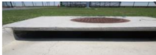
Colector de aguas pluviales
